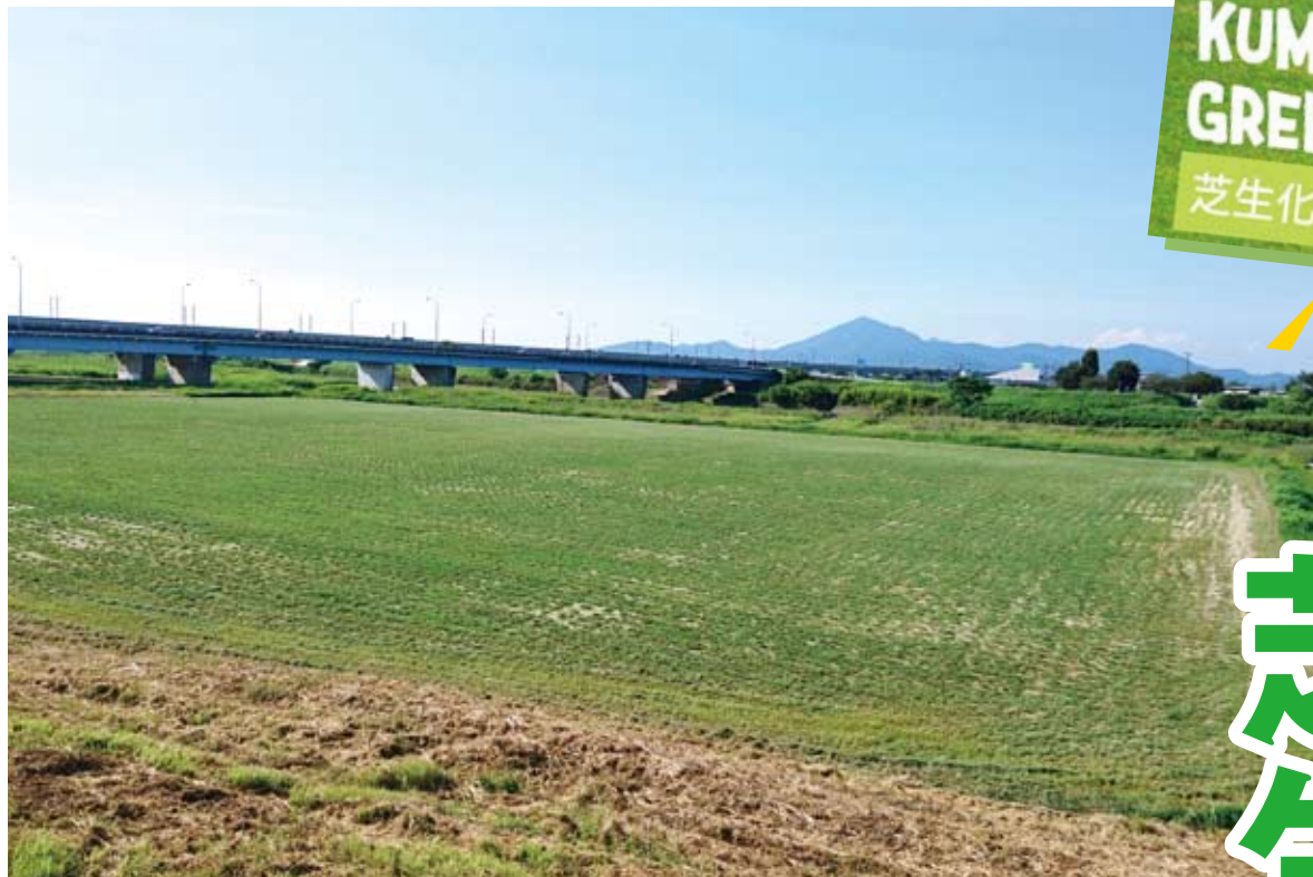
■緑川河川敷グラウンド 熊本グリーンプロジェクトの事業第1号
